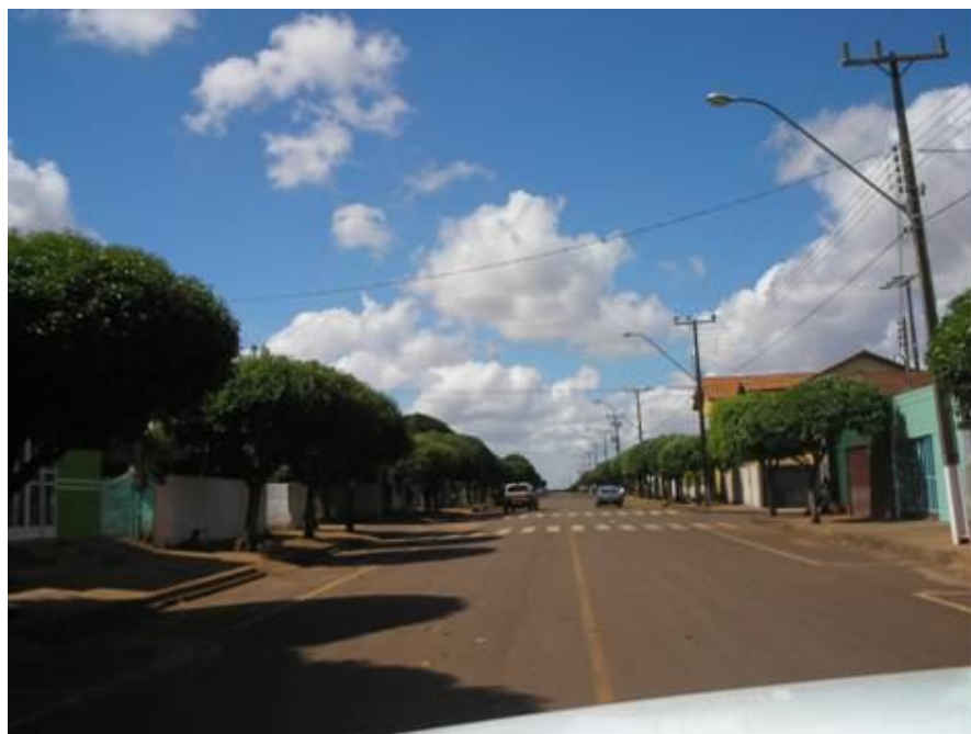
Vista da rua central da Vila de Alto Palmital. Dezembro de 2007.
